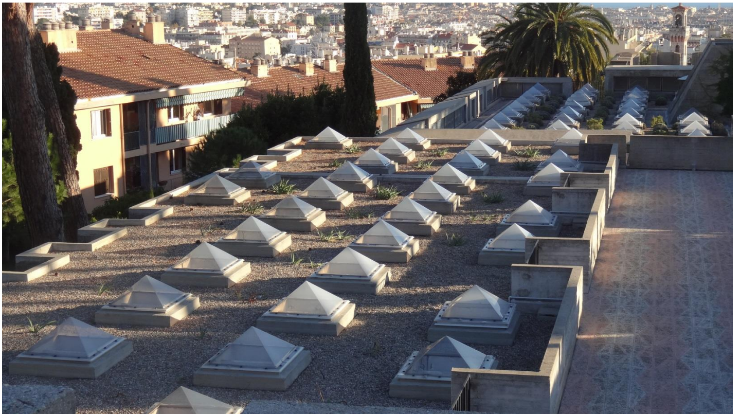
Les pyramidions qui permettent l'éclairage zénithal des salles
