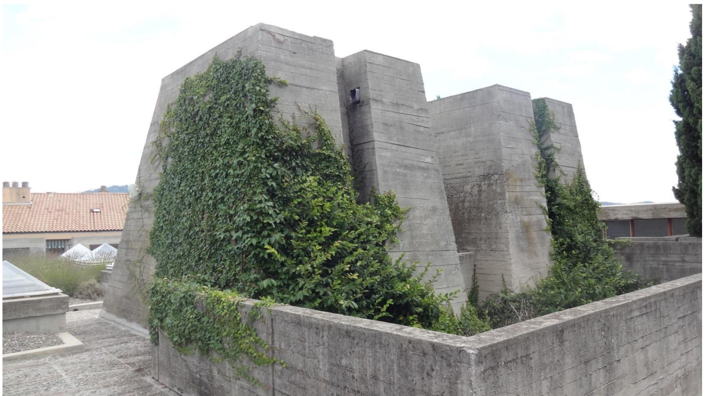
Intégration aux terrasses des cheminées des fours des ateliers de céramique et autres...
