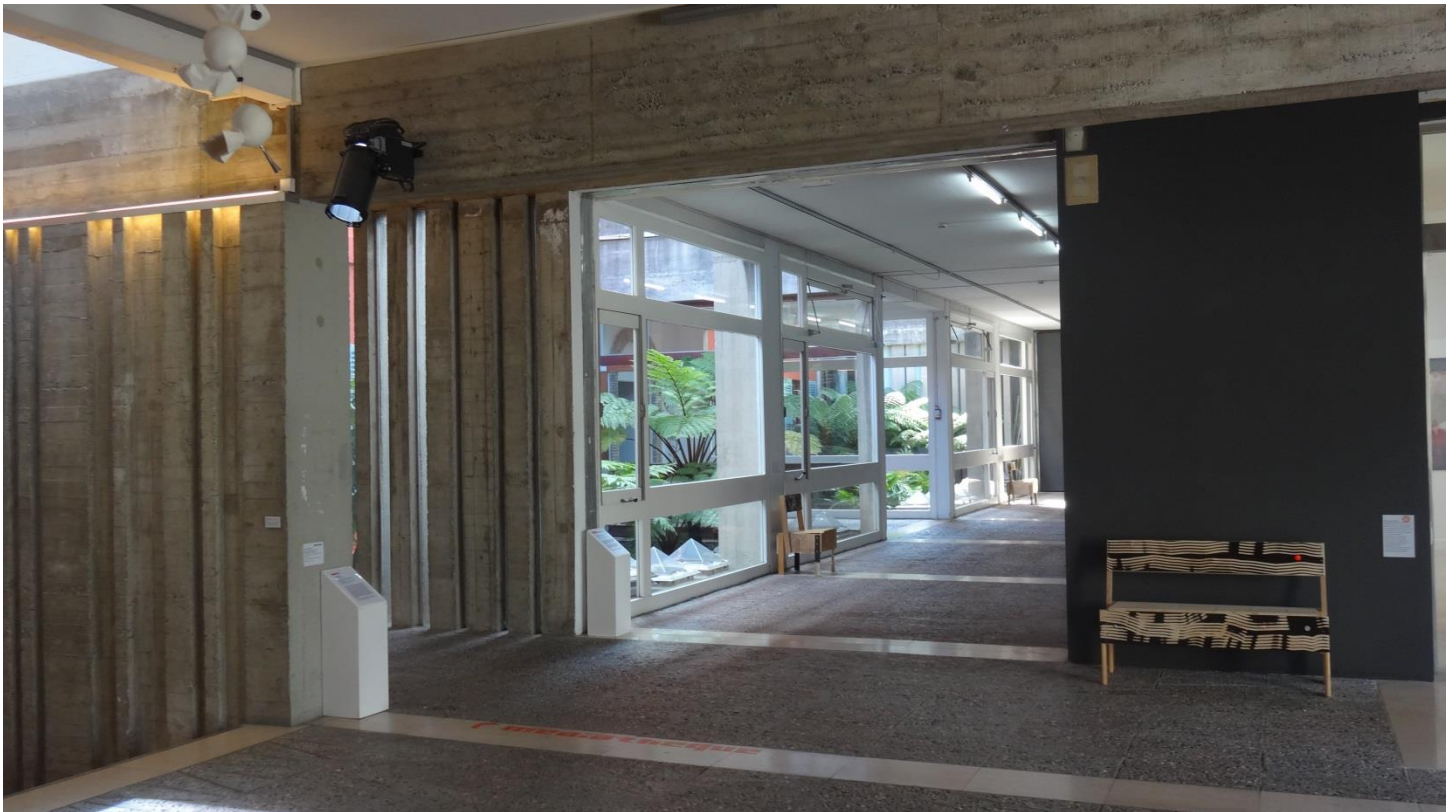
Le hall du bâtiment principal, on voit bien, comme sur la photo suivante, l'usage du béton brut disposé pour accrocher la lumière venant des ouvertures latérales et faire des sortes de sculptures verticales.... Les ouvertures zénithales dessinent aussi des motifs sur le sol...
