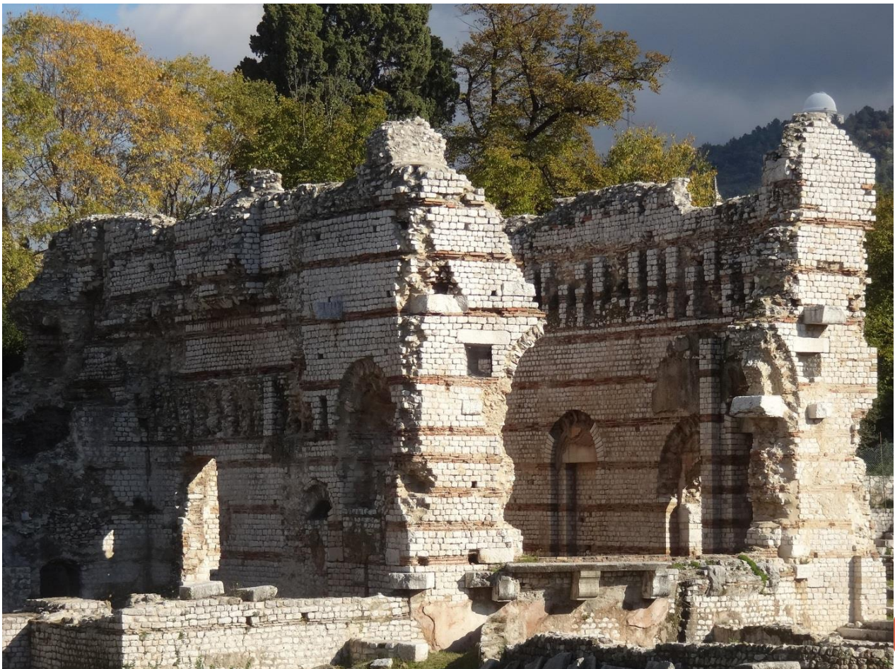
Vue d'ensemble des thermes du nord et ci-dessous le « frigidarium » avec ses murs caractéristiques des constructions romaines avec les rangs de pierres en alternance avec des rangs de briques
